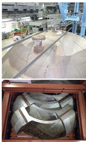
図 6-2 浜岡原子力発電所における原子炉压力容器上蓋の解体状況
