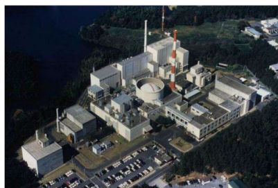
図 8-1 高速実験炉「常陽」
