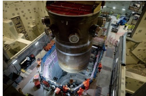
図3-7 建設中のヒンクリーポイントC原子力発電所
