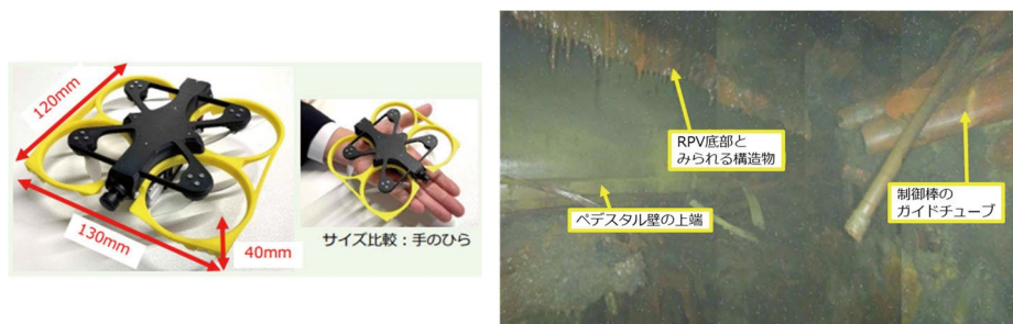
図 1-41 3号機原子炉格納容器内部調査に用いられたドローンと調査画像
