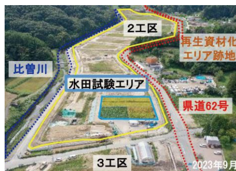
図 1-7 飯舘村長泥地区での農地造成実証事業
