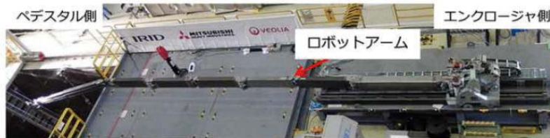
図 21 ロボットアーム最大伸長時の状況
