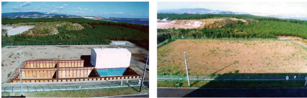
図 6-23 原子力機構の埋設実地試験における埋設段階(左)及び保全段階(右)の様子 (出典)原子力機構「埋設実地試験」
