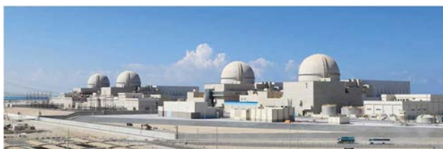
図 3-3 バラカ原子力発電所
