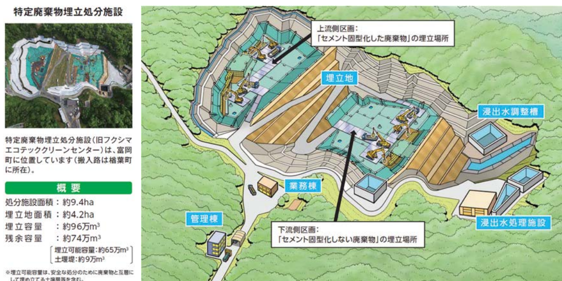
図 1-10 福島県内の管理型処分場（旧エコテッククリーンセンター）を活用した特定廃棄物の埋立処分施設
