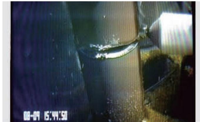
図 6 配管のプラズマアーク切断
