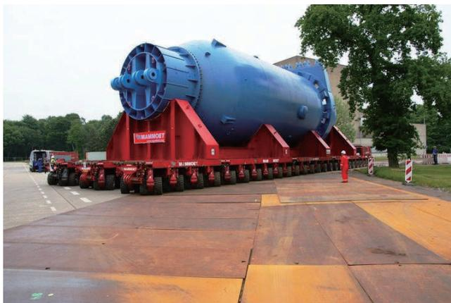
図 14 AVR の圧力容器搬出
