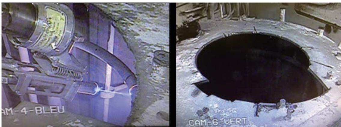
図 18 レーザー切断遠隔操作ロボットによる UP1 での作業状況
