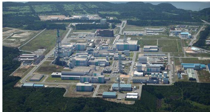
図 3-17 日本原燃（株）六ヶ所再処理工場
