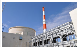
高速実験炉「常陽」
