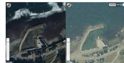
空中写真による被災前後の比較 (長橋漁港)
