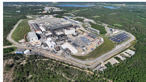
図8-8 ITERの建設状況 （2025年5月）
