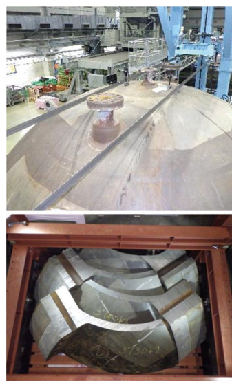
図 6-2 浜岡原子力発電所における原子炉压力容器上蓋の解体状況
