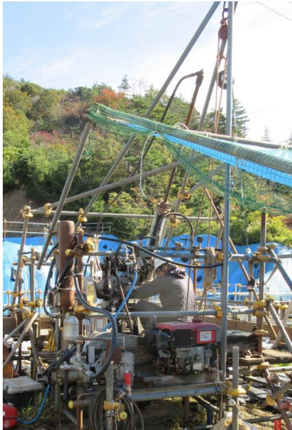
D-1トレンチの西側からの 斜めボーリング調査
