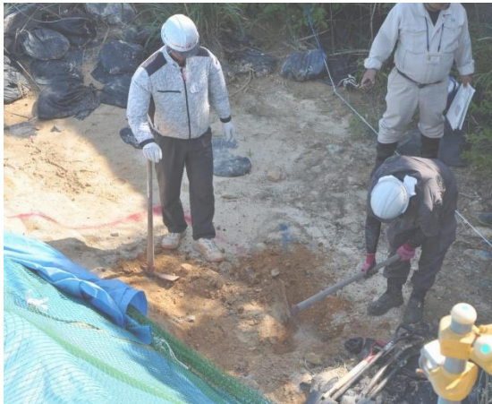
ふげん道路ピットの掘削調査 (2025年9月16日 現地調査開始)
