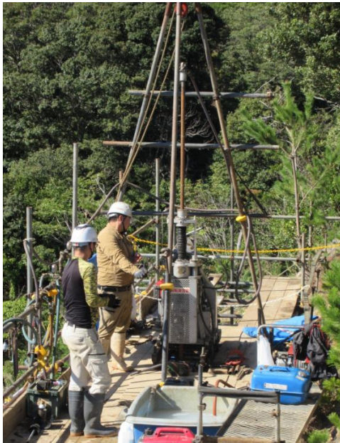
北西法面での ボーリング調査
