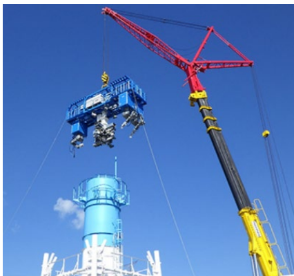
廃炉作業への地元企業の参画 (1・2号機の排気筒解体作業)
