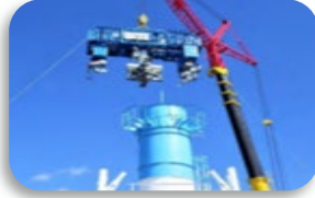
▲ 福島第一原発の排気塔解体 ((株)ピーエイブル)
