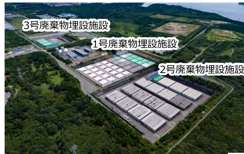
低レベル放射性廃棄物埋設センター 全景
