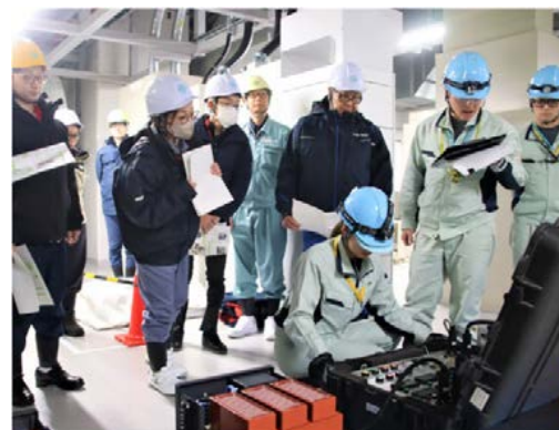
協力会社社員が電気設備の点検をする様子
