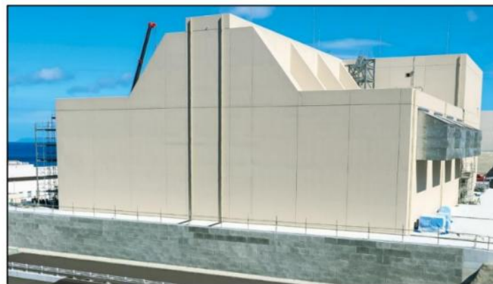
〈図-2〉 乾式貯蔵建屋の外観
