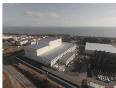
大熊町の仮設焼却施設
