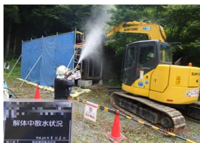
被災家屋等の解体の様子
