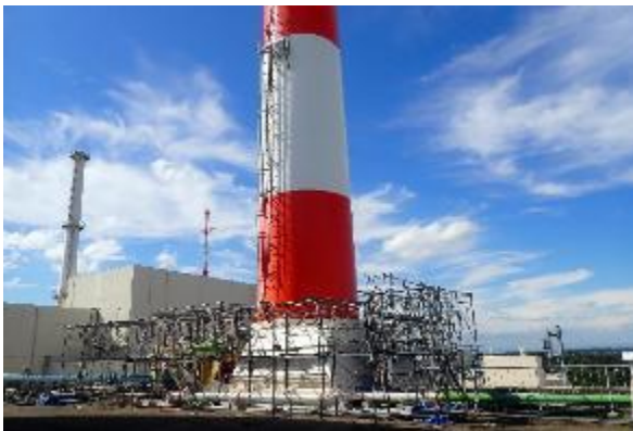
付属施設の耐震補強 (主排気筒)
