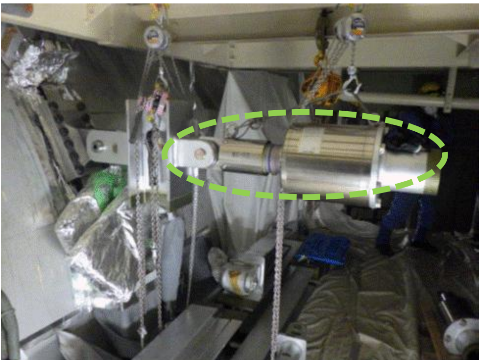
配管支持装置の新設（メカニカル防振器）
