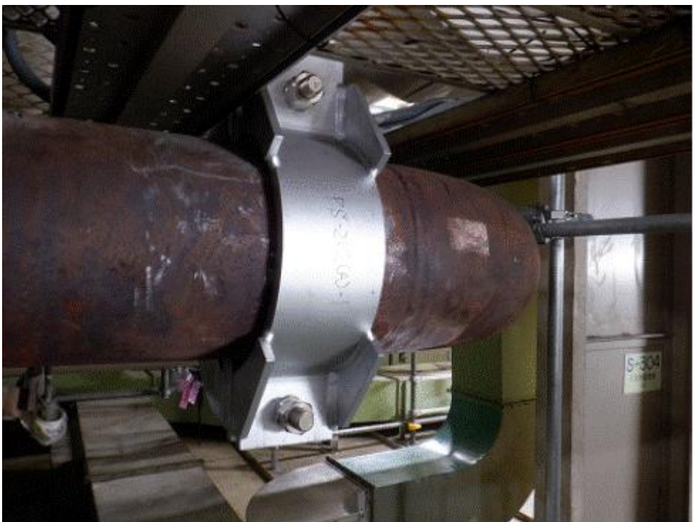
配管支持装置の交換
