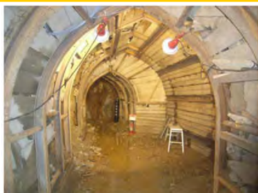
試掘坑調査 (イメージ)
