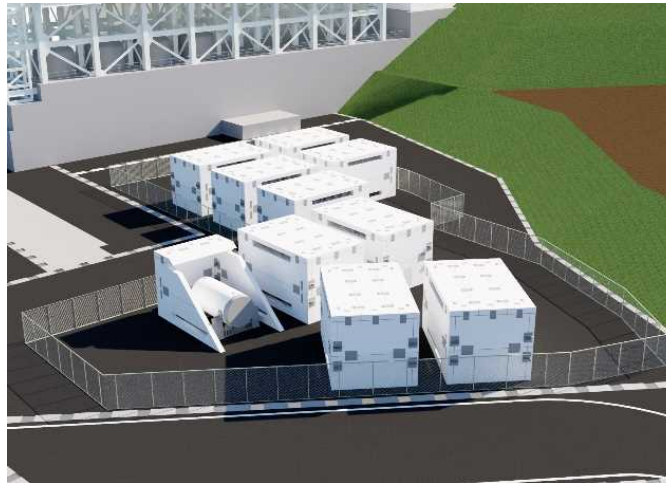
乾式貯蔵施設の外觀
