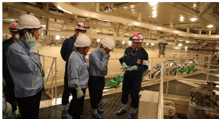
7号機原子炉建屋内
