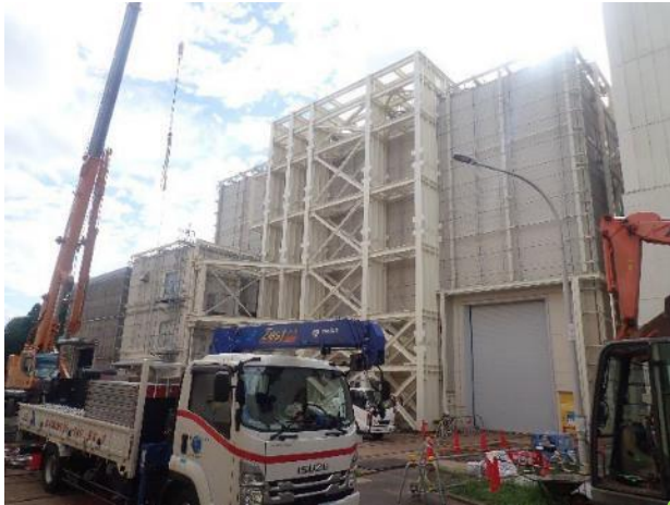
メンテナンス建物 耐震改修工事 ( ⇒ R6.11.29竣工 )
