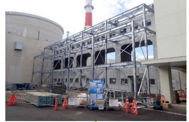
附属施設 耐震改修工事 ( ⇒ R6.9.30竣工 ) (主排気筒の耐震補強) (渡り廊下の耐震補強)
