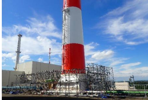
附属施設 耐震改修工事 ( ⇒ R6.9.30竣工 ) (主排気筒の耐震補強) (渡り廊下の耐震補強)
