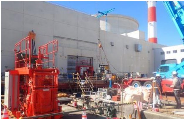
主冷却機建物 地盤改良工事 ( ⇒ R6.10.31竣工 )
