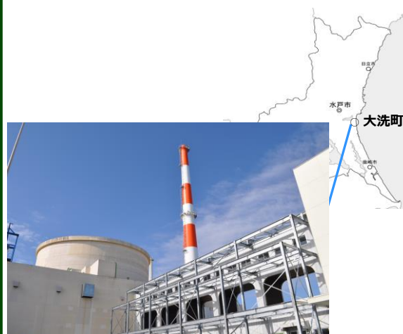
高速実験炉「常陽」
