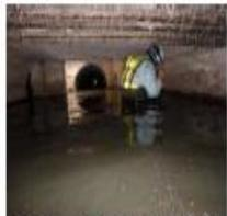
滞水した溝橋内部の目視点検
