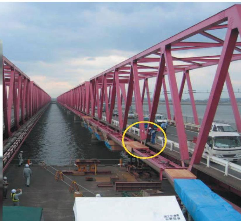
平成19年6月20日、職員による遠望目視点検中に、トラス部材の破断を発見（上り線）
