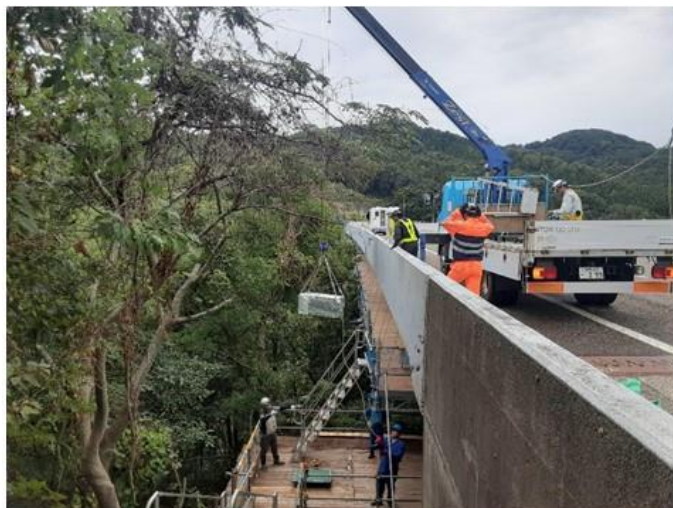
機材吊り降し
