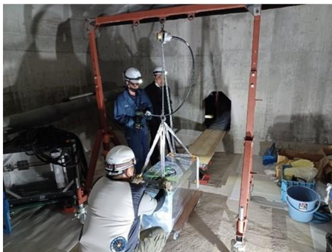
箱桁内機材移動(隔壁通過)
