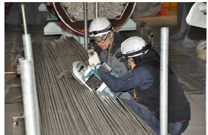
給水加熱器伝熱管の細断作業
