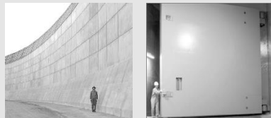
例) 左: 防波壁/右: 水密扉 写真提供: 中部電力(株)
