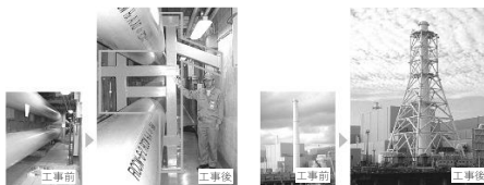
例) 左: 配管サポート改造工事/右: 排気塔改造工事 写真提供: 中部電力(株)
