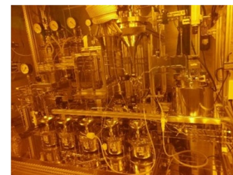
JMTRホットラボに設置された分離抽出装置
