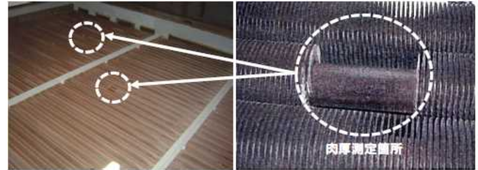
③の例：主冷却器伝熱管の肉厚確認結果
