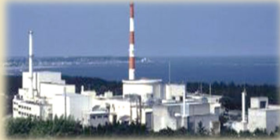
高速実験炉「常陽」
