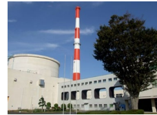
高速実験炉「常陽」
