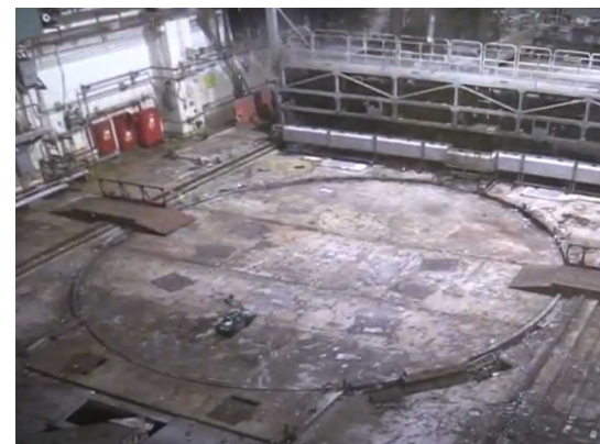
オペレーティングフロアのシールドプラグの調査
