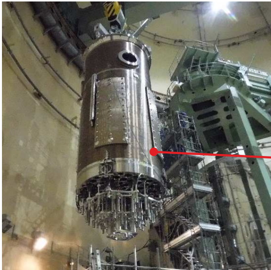
【炉内構造物取替工事】 (CIR)
