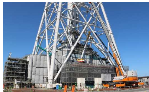
主排気筒竜巻対策工事
