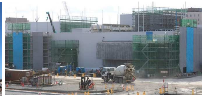
緊急時対策所設置
