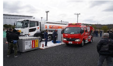
<災害時専用臨時設置給油設備>
