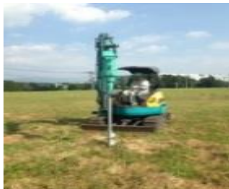
（設備設置のための調査）
