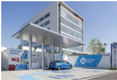
＜中規模水素ステーション＞
