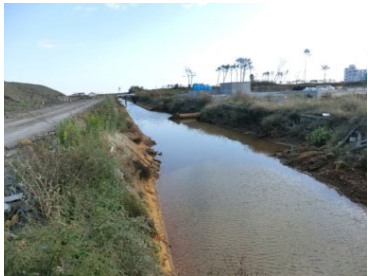
【仙台東】大堀排水路
