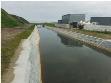
津波で損壊した排水路の復旧状況
