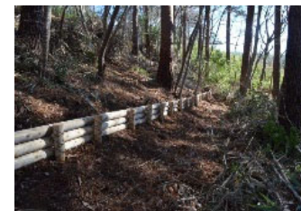
土砂移動抑制のため、筋工を施工
