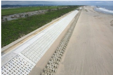
海岸堤防の復旧状況
