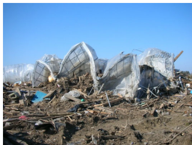
被災した園芸施設
