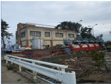
【名取川】関上排水機場
