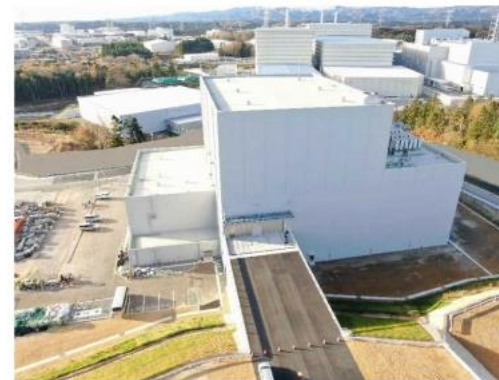
増設雑固体廃棄物焼却設備
