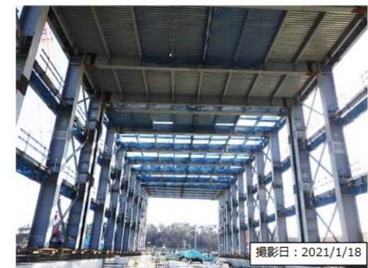
大型廃棄物保管庫第一棟
