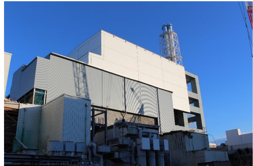
（↑ 燃料取り出し用カバーの設置） （出典：東京電力HP）
