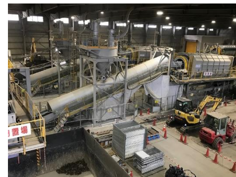
受入・分別施設(大熊①工区)
