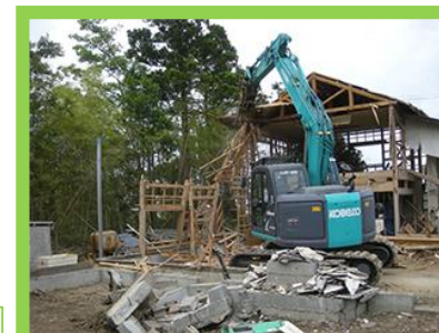
被災家屋等の解体
