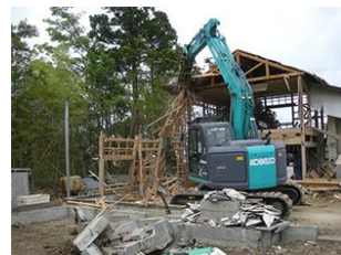
被災家屋等の解体
