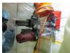
(コンクリート壁)
