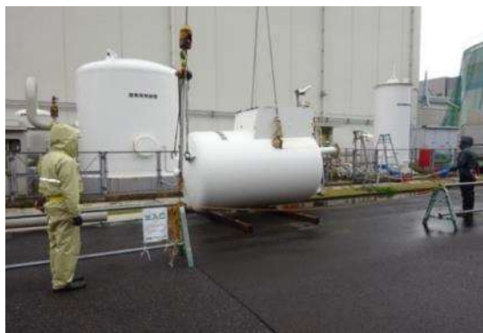
管理区域外にある設備の解体撤去
