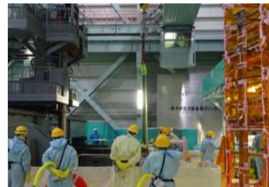
搬出・譲渡し前の新燃料除染作業
