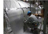
熱的切断のための火気養生
