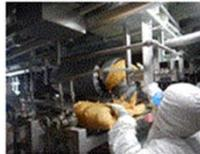
配管保温材取外し作業
