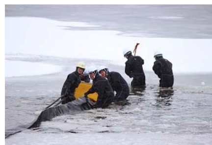
水中ポンプの投入 尾鰭沼を水源として 冷却水を確保
