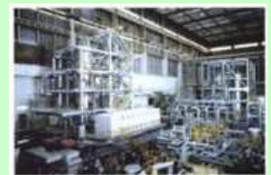
大型構造機器実証試験ループ (HENDEL)
