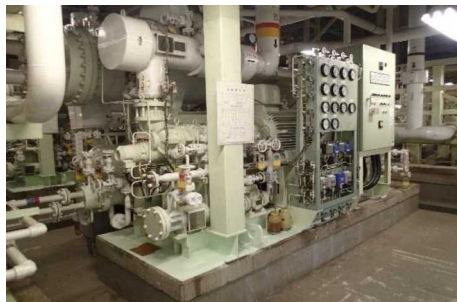
高経年化対策 プロセス系冷凍機の更新 (核燃料サイクル工学研究所)
