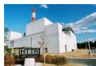
高温工学試験研究炉 (HTTR) (2019年10月 運転再開予定)
