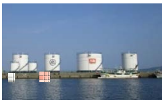
離島における油槽所
