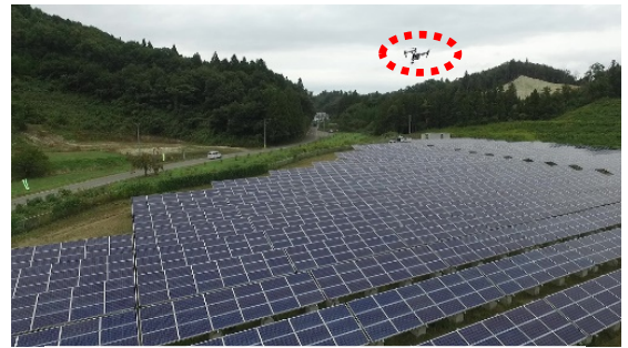
ドローンで撮影した赤外線画像の解析等により、太陽光パネルの劣化場所の特定と劣化度合いを短時間で診断できる技術の実用化に向けた実証研究 (株)F E P [福島県伊達市]等
