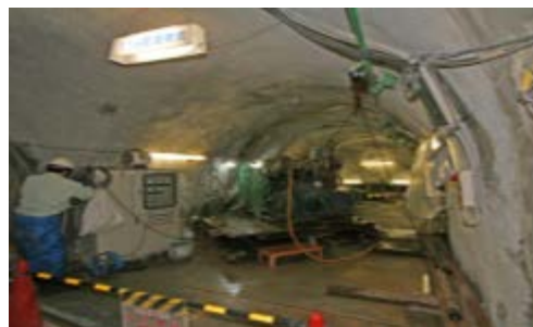
深地層の研究施設における物質移行試験作業
