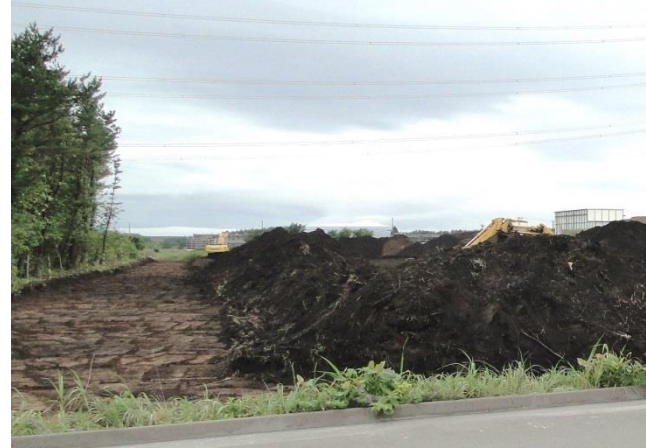
建設所における敷地造成工事例 (定検事務所)
