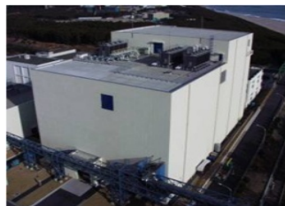
低放射性廃棄物処理技術開発施設の震災復旧 (核燃料サイクル工学研究所)
