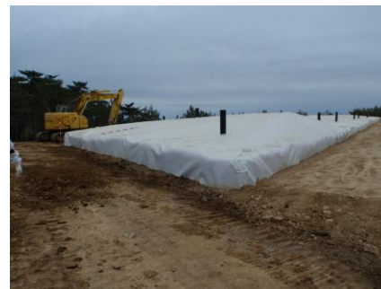
伐採木搬入状況 (3/27撮影)
