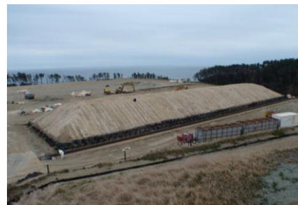
1槽目設置完了 (1槽目：3/27撮影)
