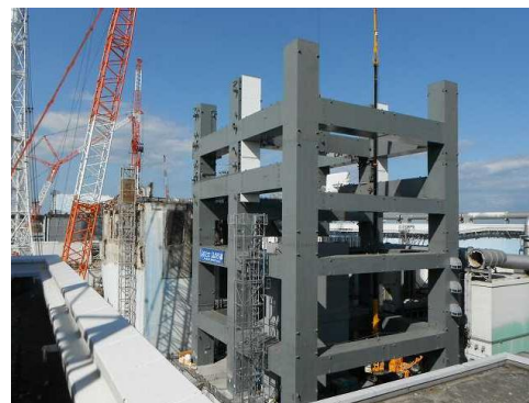
鉄骨建方3節目完了・ 4節目着手済み（3/26）
