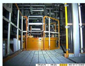
トラス室内の様子
