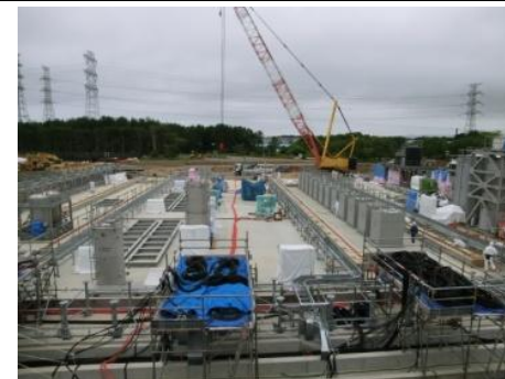
多核種除去設備設置エリア全景(7/21)
