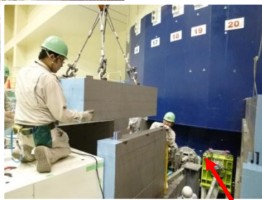
ずれた遮蔽体の積み直し作業 約530個、総重量約2,800トン
