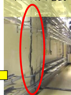
ビーム輸送トンネルで大亀裂
