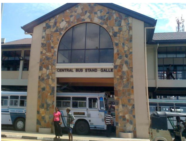
被災地（４）被災したバス停を再建。1階を中空にした新たなターミナル。
