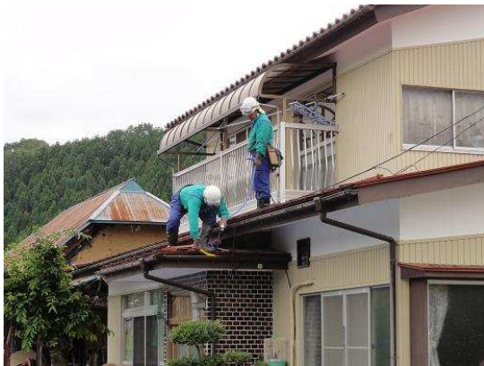
雨樋・屋根の掃除
