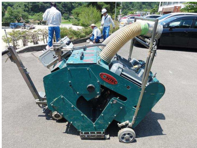
コンクリート等(ブラスト法による剥離)
