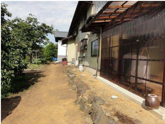
土壌の剥離(手作業)
